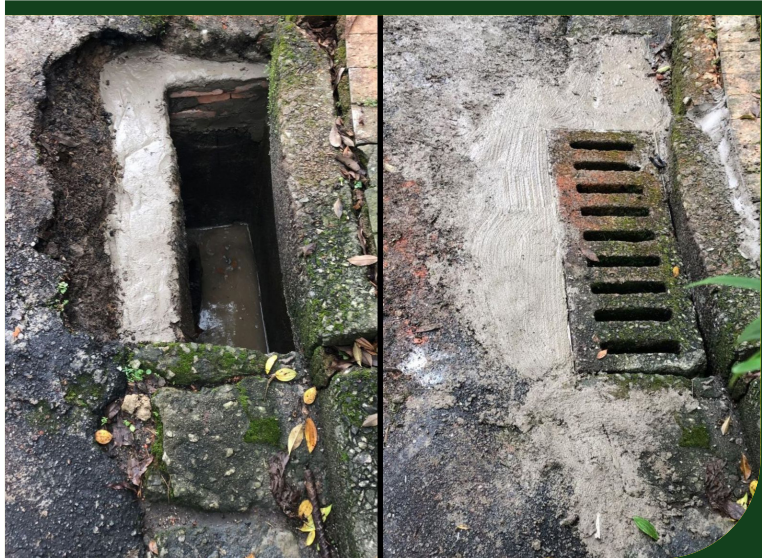
Reforma de caixa no cruzamento das ruas Adilson Buló com Prof. João Carlos de Alencastro Guimarães
