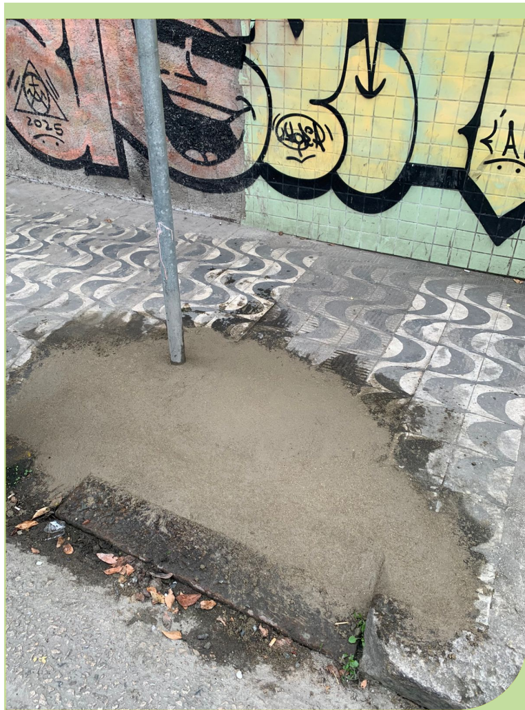
Reparo em calçada na Avenida São Francisco, em frente ao número 263, no Centro
