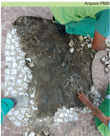
Reparos no piso mosaico na Avenida Vicente de Carvalho, no Canal 3
