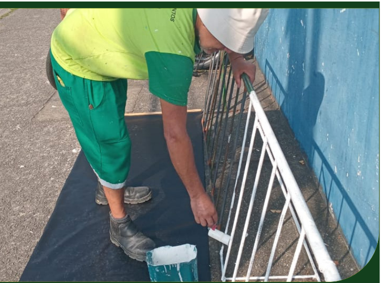
Reparos e pintura dos bicicletários em frente ao Centro Esportivo e Recreativo do Dale Coutinho
