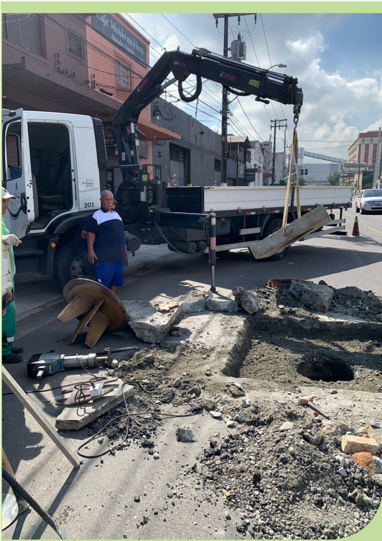
Troca de laje com poço de visita na Rua João Pessoa, no Centro
