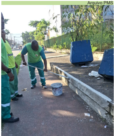
Pintura de mureta no final da Avenida Afonso Schmidt, no Castelo
