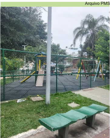
Continuação da instalação de alambrado da Praça Olímpio Lima
