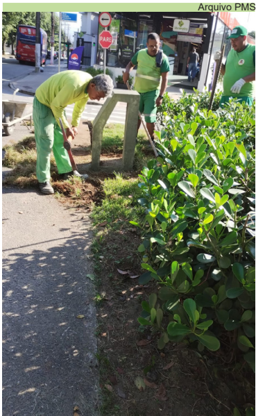
Colocação de cordoneis de bolinha na calçada na Praça Paulo Roberto Medeiros
