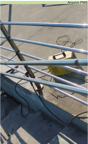
Corrimão instalado na Ponte Edgard Perdigão, na Ponta da Praia
