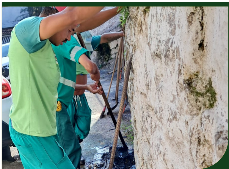
Limpeza de córrego e caixas na Rua José Francisco dos Santos, na Vila São Bento
