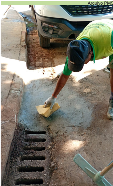
Conserto de boca de lobo na Rua Almirante Tamandaré, no Macuco
