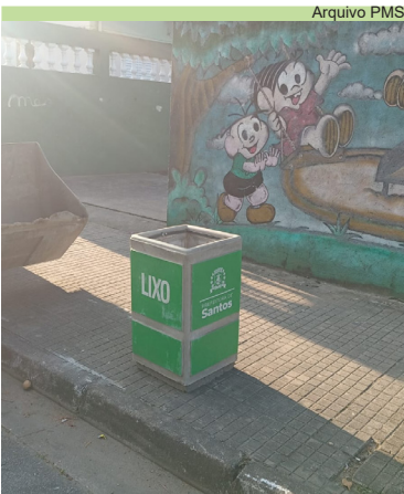
Serviço de instalação de lixeira na quadra da Arena Caneleira
