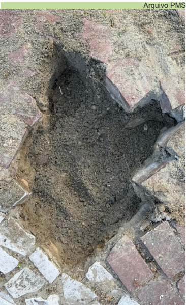
Reparo no piso mosaico de canteiro central no bairro Aparecida
