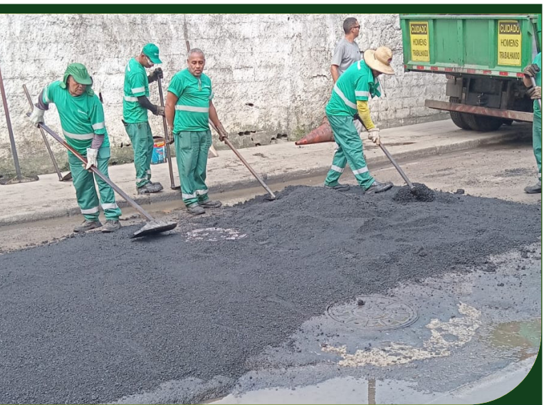
Instalação de dois poços de visita: Avenida Nossa Senhora de Fátima com Rua Ana Santos, no Chico de Paula
