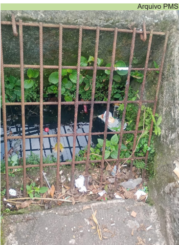
Serviço de limpeza de caixas na Rua 9 de Julho, no Morro Marapé
