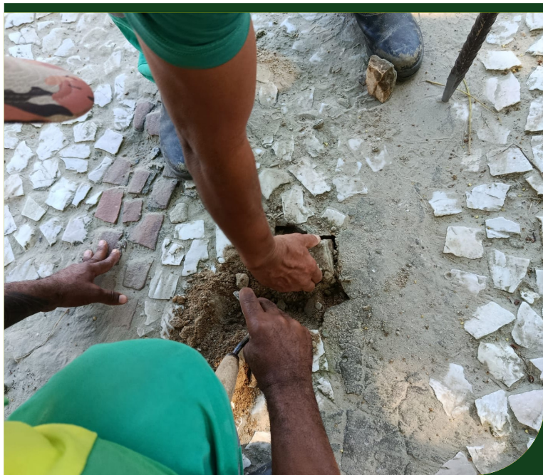
Conserto do piso mosaico na Avenida Bartolomeu de Gusmão, próximo à areia da praia
