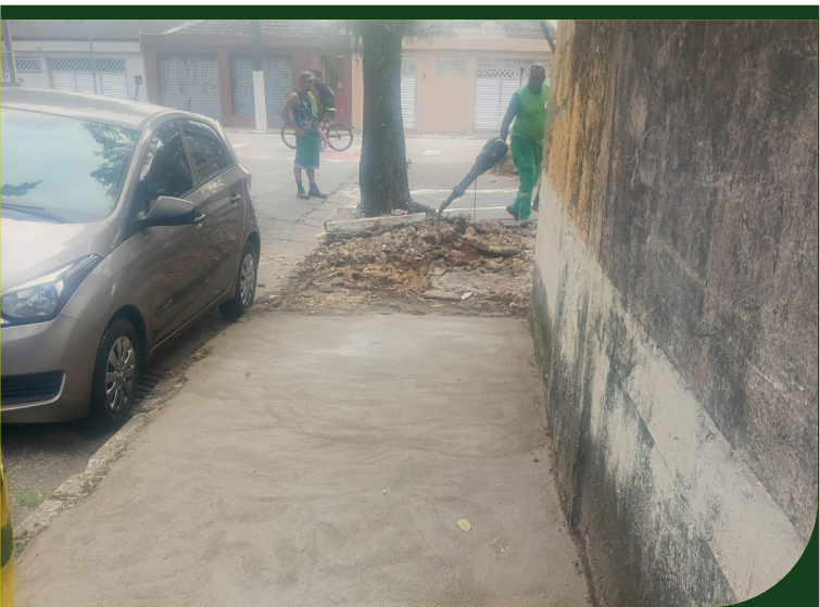
Reparo em calçada na esquina da Avenida Afonso Schmidt com Rua Fausto Feliciano Brusarosco, no Castelo
