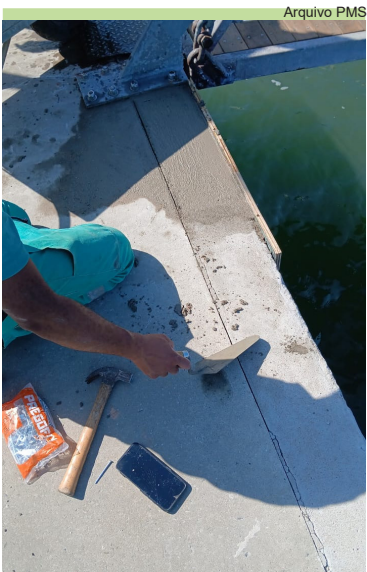
Reparo com massa no piso do píer da Ponte Edgard Perdigão, na Ponta da Praia
