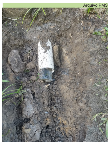
Substituição de cano de drenagem da Rua Júlio Murdocco, no Caruara
