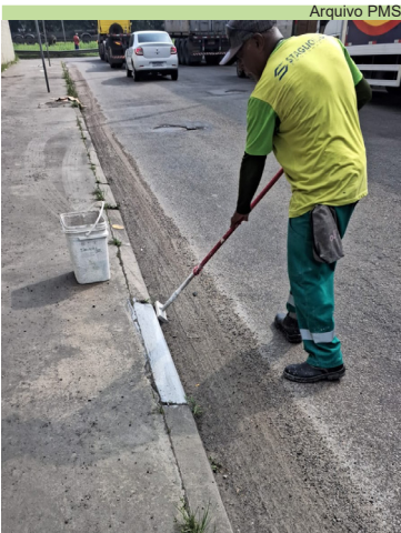
Pintura de guias e postes na Rua Ary Barroso, no Chico de Paula
