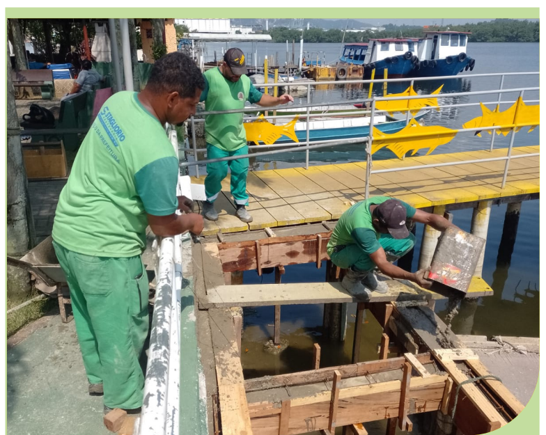
Concretagem de formas para o píer do flutuante da Ilha Diana
