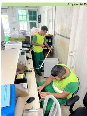
Adequação de balcão da recepção da Policlínica do Monte Cabrão
