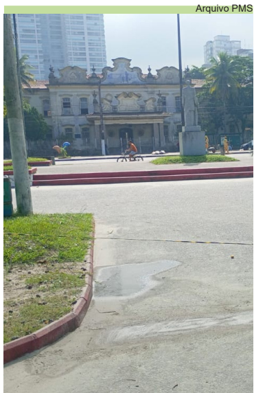
Reparo com massa na alameda do jardim em frente à Etec Escolástica Rosa, na Aparecida
