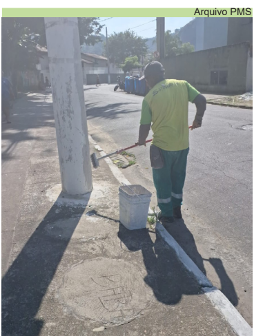
Pintura de guias e postes na Praça Júlio Dantas, no Santa Maria
