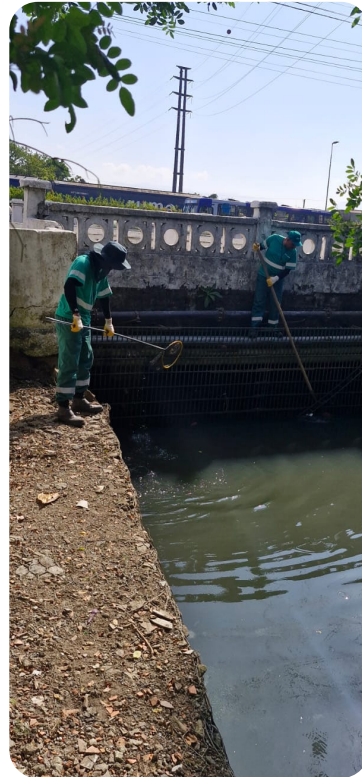
Limpeza no sistema de drenagem na Rua Cidade de Cunha
