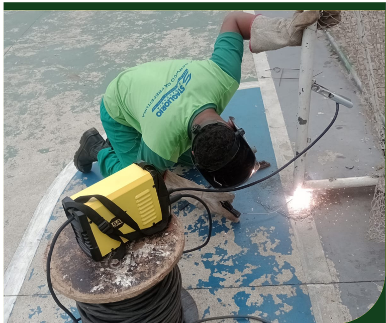
Soldagem de trave de gol caixote e uma travessa de alambrado na quadra esportiva da Praça Nicanor Ortiz
