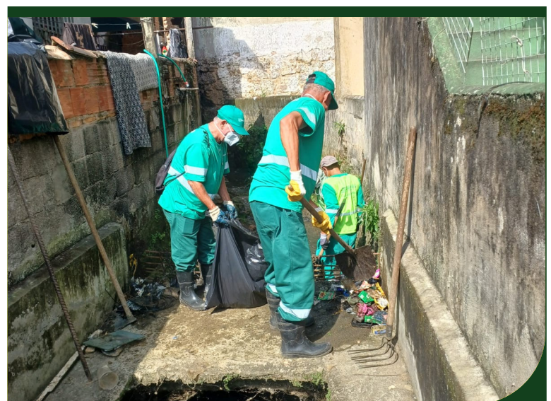
Limpeza de vala e caixa na Rua José Francisco dos Santos, na Vila São Bento
