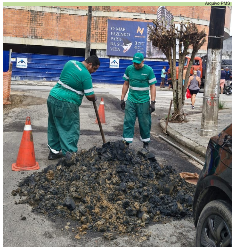
Limpeza no sistema de drenagem na Rua Cidade de Santos, na Ponta da Praia
