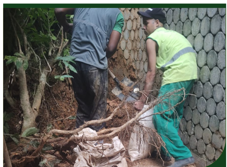
Limpeza de terreno após deslizamento de morro na Rua 12, no Morro Nova Cintra
