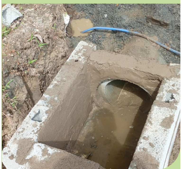
Construção de caixa de passagem na Rua das Palmas, no Caruara
