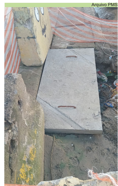
Instalação de tampa de concreto no Caminho São Jorge, número 55, no Morro do Tetéu
