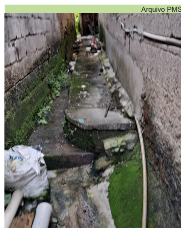
Serviço de limpeza de córrego na Rua Brigadeiro Newton Braga
