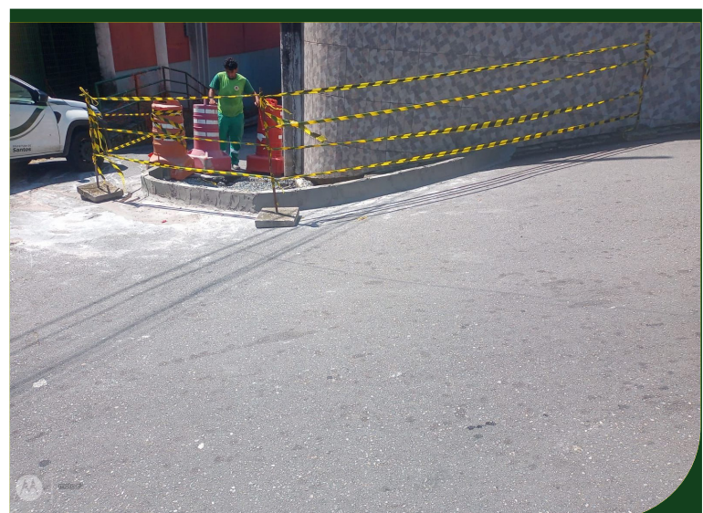
Construção de mureta de contenção na esquina das ruas São Marcos e São Luiz, no Morro São Bento
