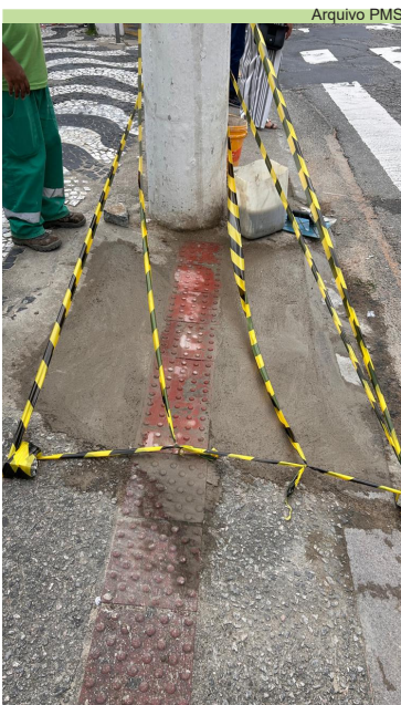
Reparo em rampa de acessibilidade na Avenida Ana Costa, número 499, no Gonzaga
