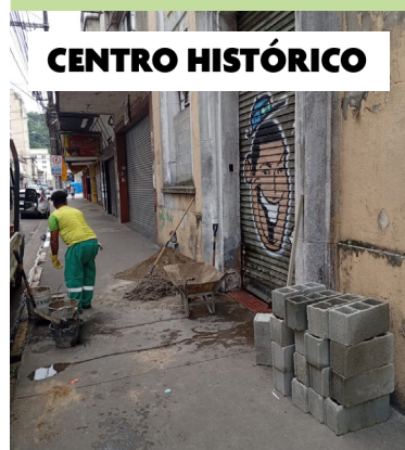
Emparedamento de prédio que abrigava a empresa Telefônica
