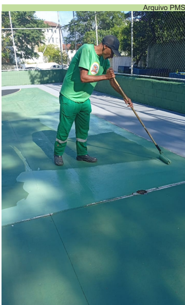
Pintura do piso e das demarcações na quadra poliesportiva na Rua 2, no Ilhéu Alto
