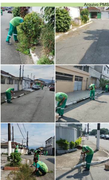
Pintura de guias e postes na rua Santa Rita de Cássia, no Rádio Clube
