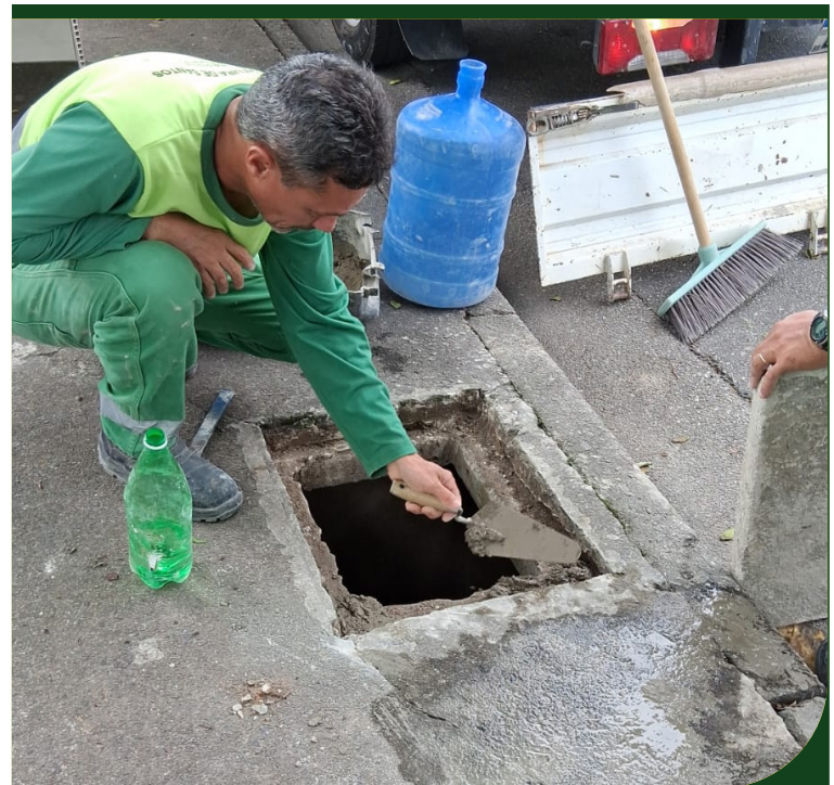
Conserto na tampa da caixa de passagem na Rua Cyro de Athayde Carneiro, número 47, na Ponta da Praia
