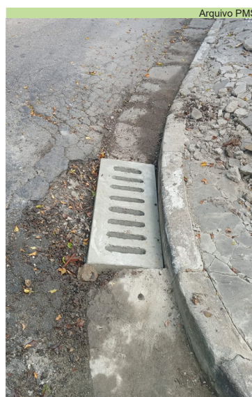
Substituição de boca de lobo na Rua Etelvina de Paula Freire, no Piratininga
