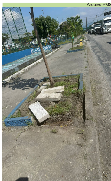
Instalação de cordoneis na Praça Antônio Guilherme Gonçalves, no São Manoel
