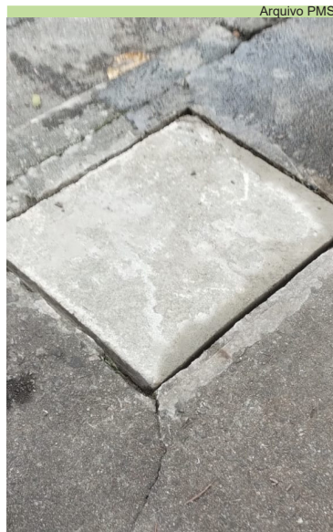
Reparo em tampa de concreto na Avenida Almirante Cochrane, número 302, no Embaré
