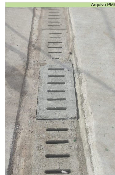
Substituição de boca de lobo quebrada na Arena Caneleira
