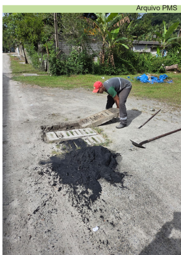
Limpeza de caixas de drenagem das ruas Um, Dois e Três
