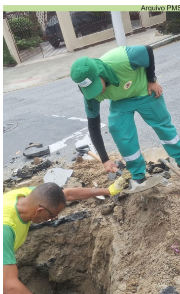
Manutenção asfáltica: esquina das ruas Rio de Janeiro com Adolpho Assis
