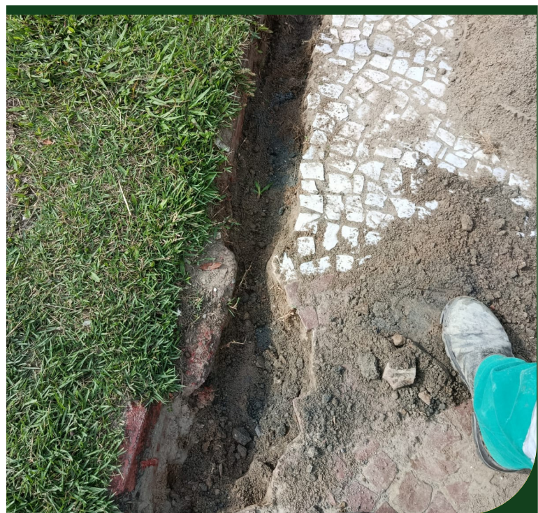
Reparos no piso mosaico na Avenida Bartholomeu de Gusmão, em frente ao número 133, na Ponta da Praia
