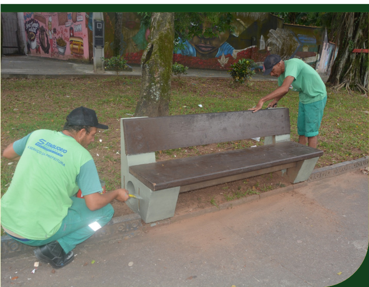
Pintura da mureta externa e conjuntos de mesas e banquinhos na Praça João Antônio Sevilhano, na Caneleira
