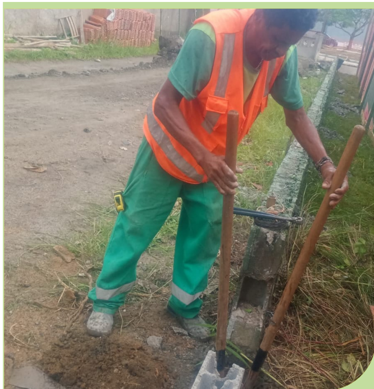
Conserto de alambrado na sede da Coordenadoria Técnica, no Caruara
