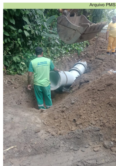
Instalação de manilhas na Rua das Palmas
