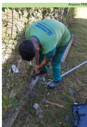
Reparos no alambrado da UME Noel Gomes Ferreira
