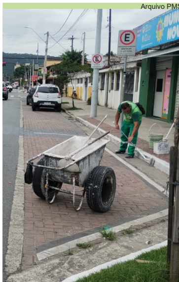
Pintura de postes e guias nas ruas Álvaro Guimarães e Av. Hugo Maia, no Rádio Clube
