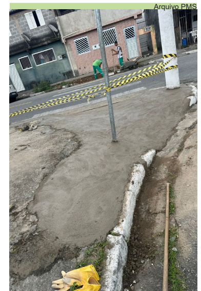
Instalação rampas de acessibilidade na Praça Maria Baiana, no Rádio Clube
