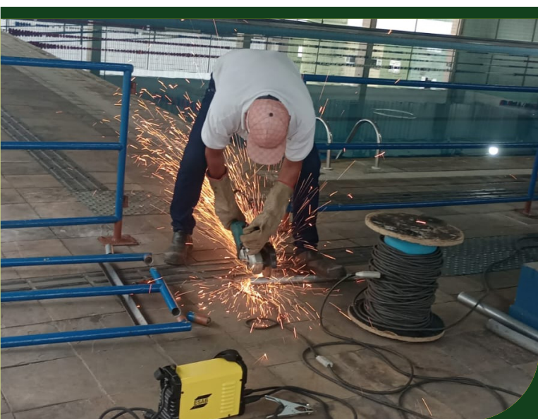
Soldagem de portão de acesso à entrada da piscina no Centro Esportivo M.Nascimento Júnior
