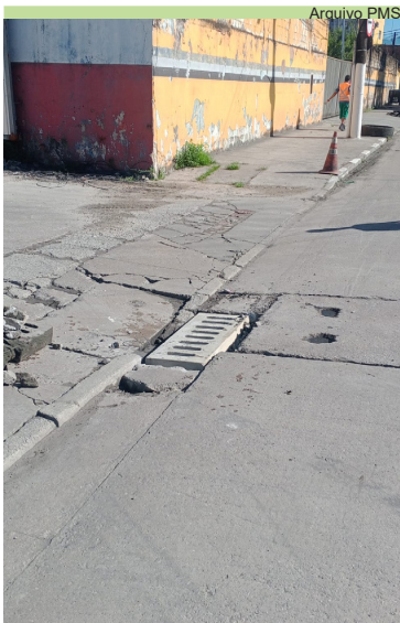
Substituição de bocas de lobo na Rua Ana Santos, no Chico de Paula
