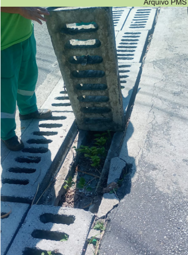
Limpeza de grelhas na Rua 2, no Morro Marapé
