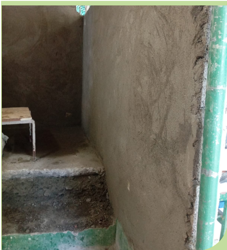
Reboco de paredes da base de apoio no Monte Cabrão
