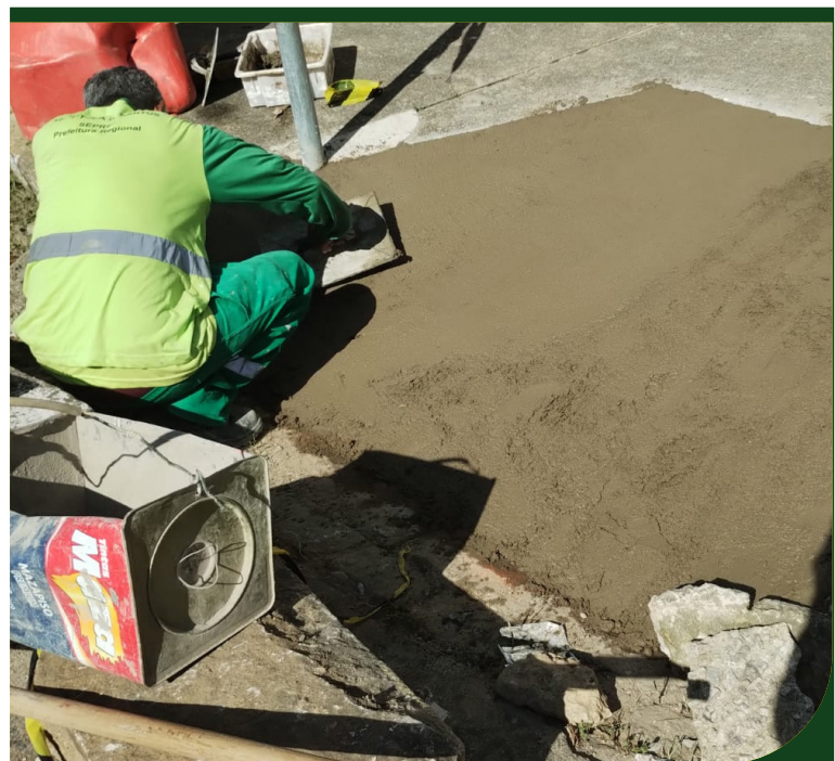
Finalização de rampa de acessibilidade na esquina das ruas Ministro Xavier de Toledo com Teixeira de Freitas
