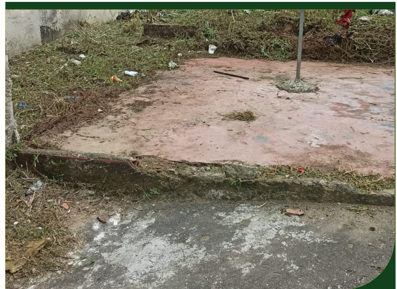
Corte de mato e limpeza na Rua 3, em frente ao número 161, no Morro Santa Maria
