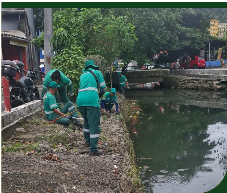
Limpeza manual e capinação no talude do canal Babalorixá Vivaldo Pires de Carvalho, no Sabóó
