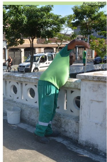
Pintura de mureta do canal da Avenida Eleanor Roosevelt, no São Jorge
