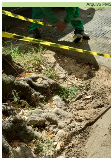
Abertura de berço na Rua Mato Grosso, em frente ao número 367, no Boqueirão
