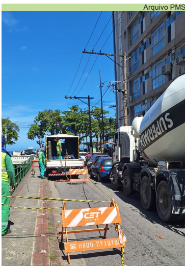
Reparos no guarda-corpo do Canal 5, Avenida Almirante Cochrane
