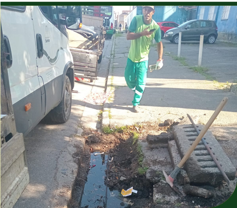
Reparos, nivelamento e substituição de bocas de lobo, na Rua Esculápio César Paiva, número 270, no Rádio Clube
