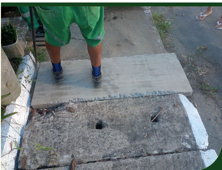
Troca de tampa de concreto na Rua Coronel Galhardo, em frente ao número 378, no Morro Nova Cintra
