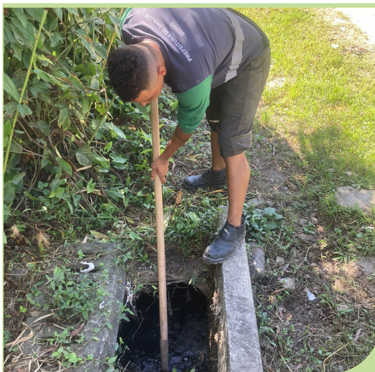
Limpeza de caixas de drenagem nas ruas São José e Santo Antônio
