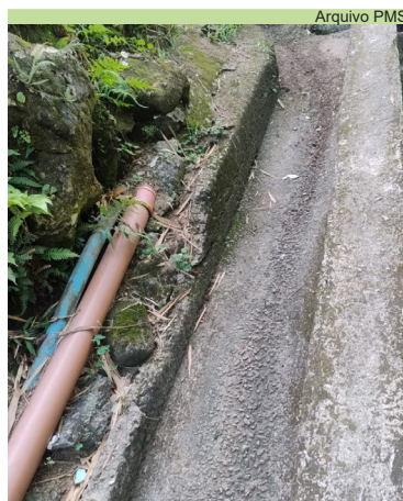
Limpeza de canaleta e escada hidráulica na Rua 8, no Morro José Menino
