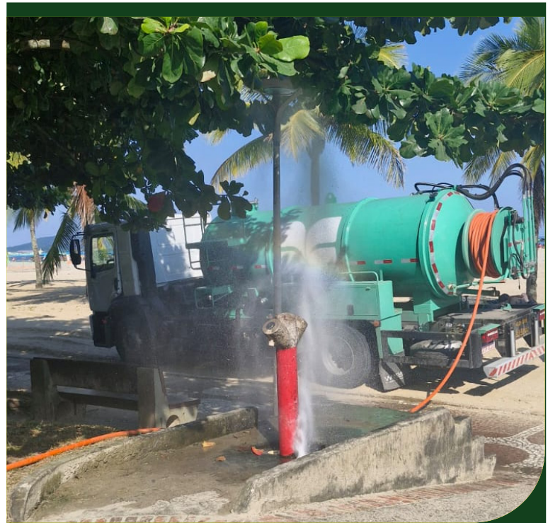
Hidrojateamento no sistema de drenagem dos chuveirinhos da orla da praia entre a divisa e o canal 3
