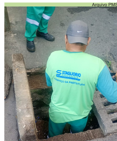
Limpeza de grelhas e caixas na Rua Getúlio Vargas, no Saboó
