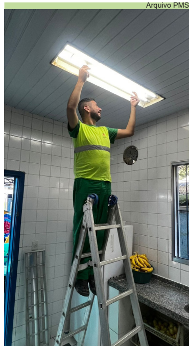
Substituição de lâmpadas na UME Monte Cabrão
