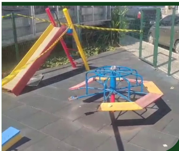
Manutenção em brinquedo do playground, entre a Av. Mário Covas e a Rua Coronel Raposo de Almeida
