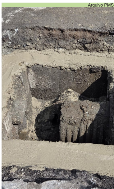
Nivelamento de laje e instalação de poço de visita na Rua Zelnor de Paiva Magalhães
