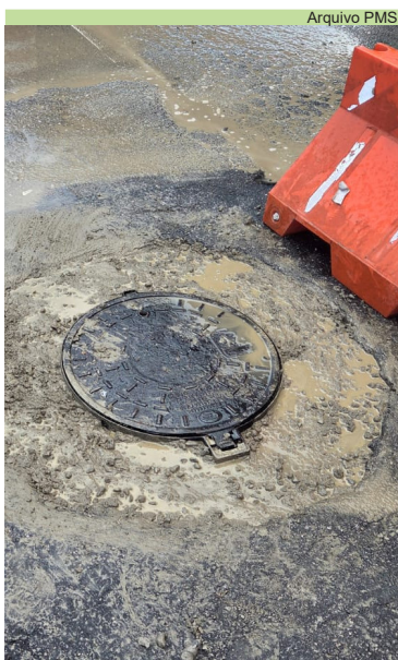
Instalação de poço de visita na Av. Anchieta próximo à Rua Ilha Bela, no Chico de Paula
