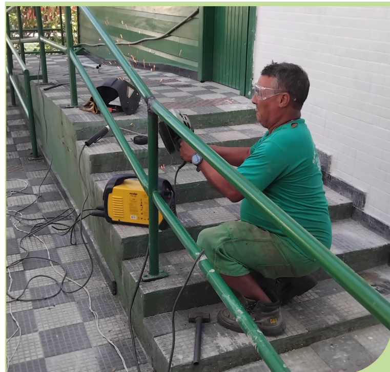
Manutenção do guarda-corpo da Policlínica do Monte Cabrão
