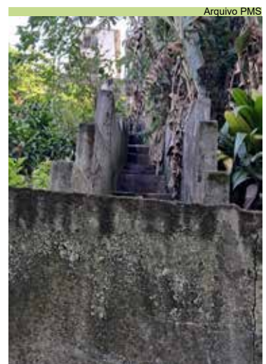
Limpeza de grelhas e escada hidráulica na Rua São Caetano, no Morro São Bento
