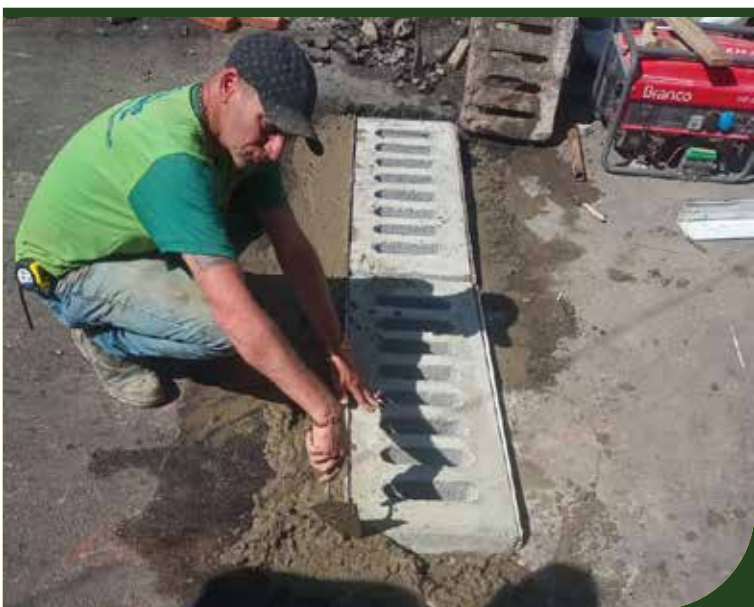
Troca de grelhas na Estrada João Baptista, em frente ao número 148, no Morro Penha
