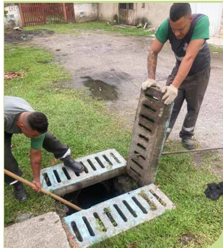
Limpeza de caixas de drenagem das ruas Trusilva, Vila Rica e Antônio Malvão, no Caruara
