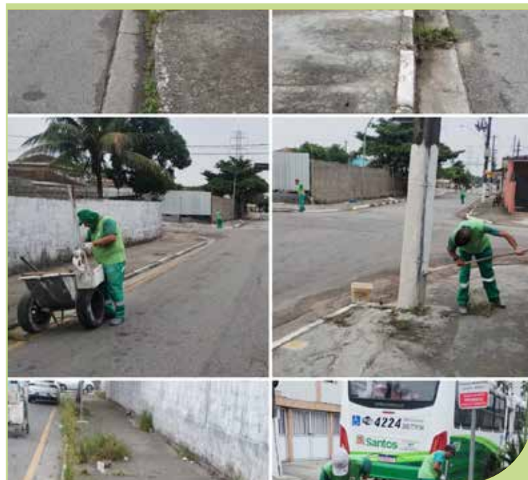
Rádio Clube: retirada de mato e pintura de guias e postes na Kleiber Facundo Leite
