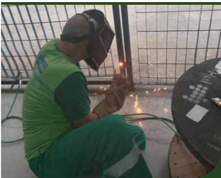
Manutenção e soldagem de portão de ferro na UME Terezinha Maria Calçada Bastos, no Morro São Bento
