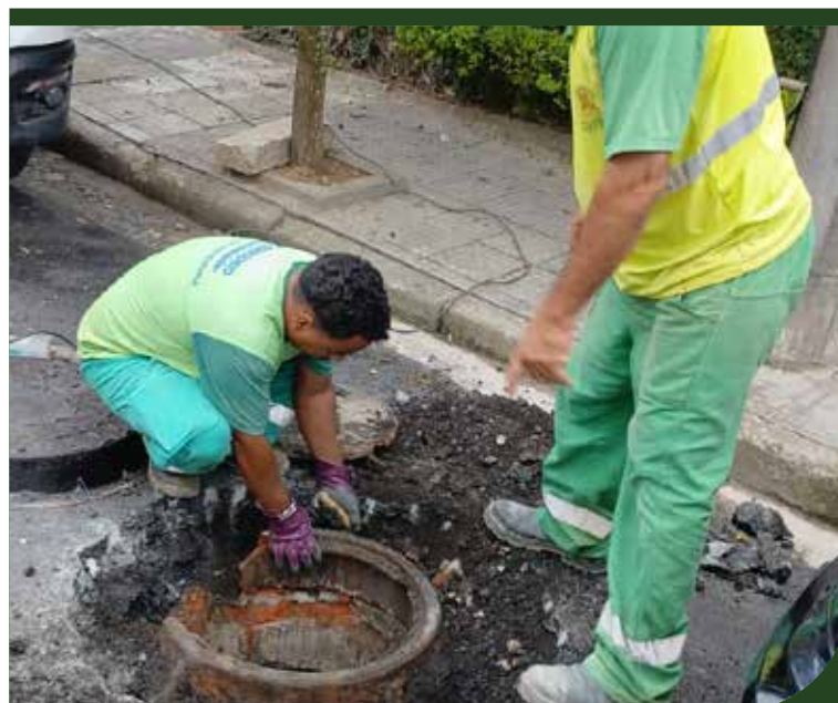
Troca de poço de visita na Rua Cidade de Santos, em frente ao número 33, na Ponta da Praia
