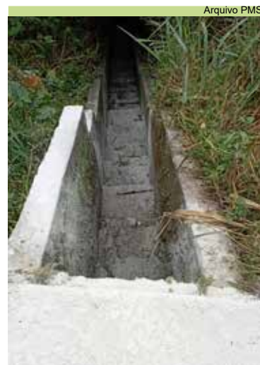
Serviço de limpeza de grelhas na Rua Santa Valéria, no Morro São Bento
