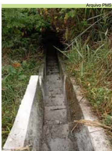
Limpeza de escada hidráulica na Rua São Miguel, no Morro São Bento
