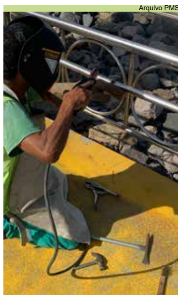
Soldagem do guarda-corpo do Emissário Submarino
