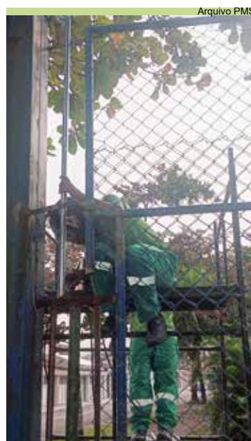
Soldagem dos vãos entre a coluna da quadra e o alambrado da quadra da Divinéia
