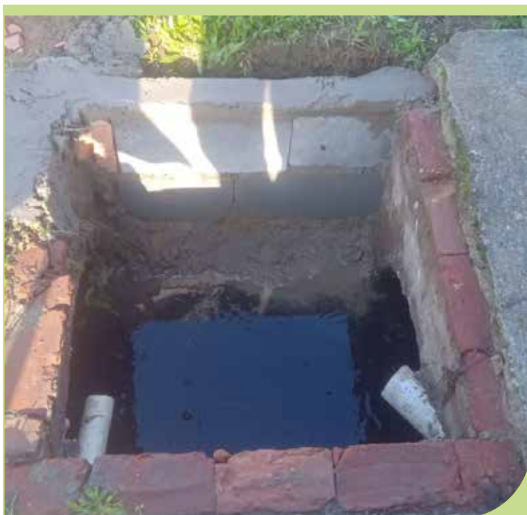
Reparos na caixa de passagem na Rua Particular A, no Caruara
