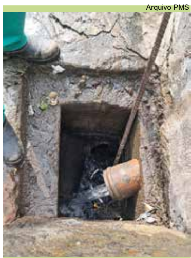
Limpeza de caixa de drenagem na Rua Santa Marta, no Morro São Bento
