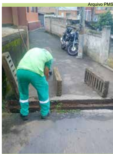
Serviço de limpeza de grelhas na Rua São Felipe, no Morro São Bento
