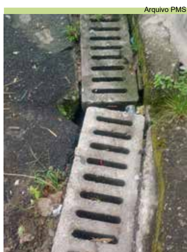
Limpeza de grelhas na Rua São João, no Morro São Bento
