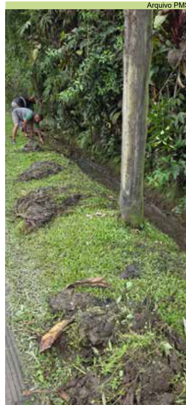
Limpeza de vala na Rua Caramuru, no Caruara
