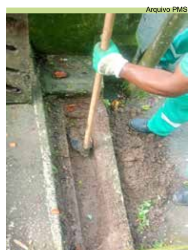
Serviço de limpeza de grelhas na Rua 10, no Morro Pacheco
