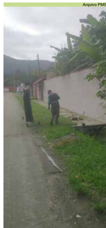
Roçada nas ruas 5, 6, São José e Xavantes, no Caruara
