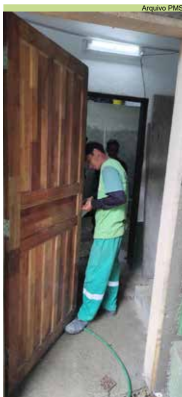
Instalação de porta na base de apoio do Monte Cabrão
