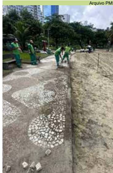
Conserto das guias e no piso mosaico da calçada frente ao chuveirinho 5
