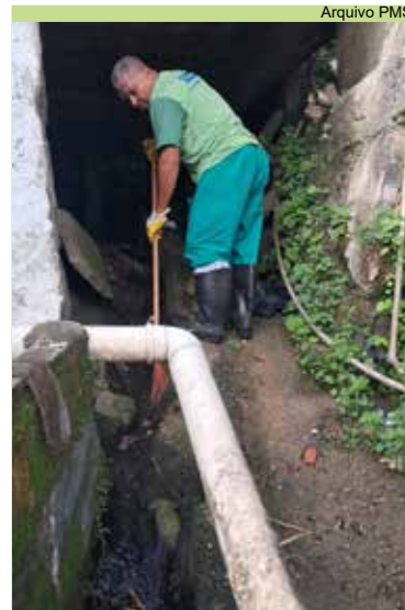
Serviço de limpeza de caixas e escada hidráulica no Nicho 3, no Monte Serrat
