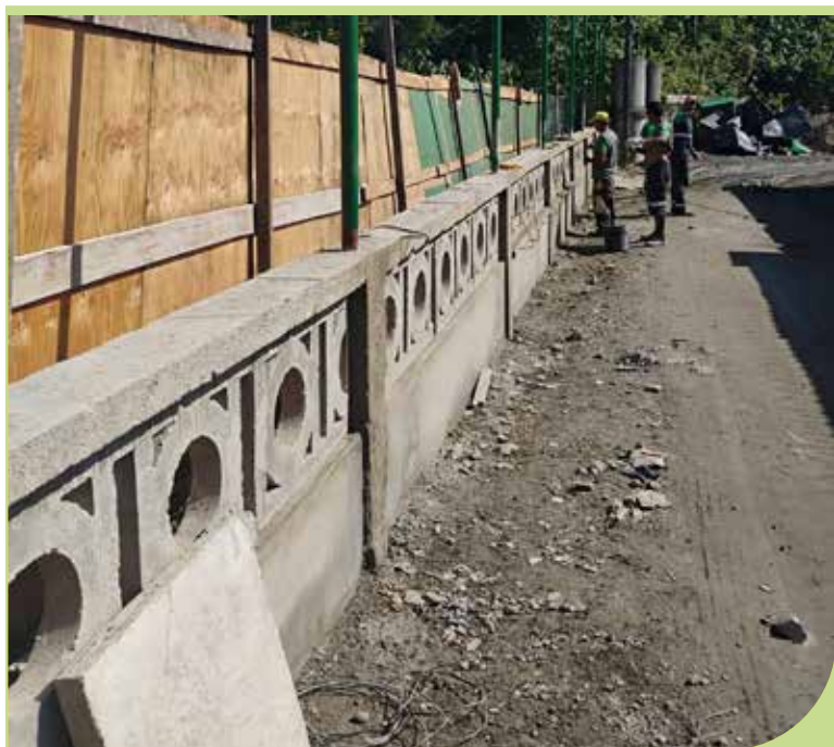
Aplicação de reboco na mureta da Coordenadoria Técnica, no Caruara
