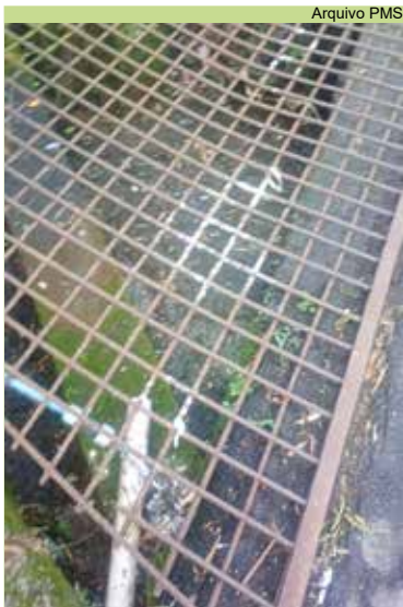
Limpeza de grelhas na Rua Central, no Morro Saboó
