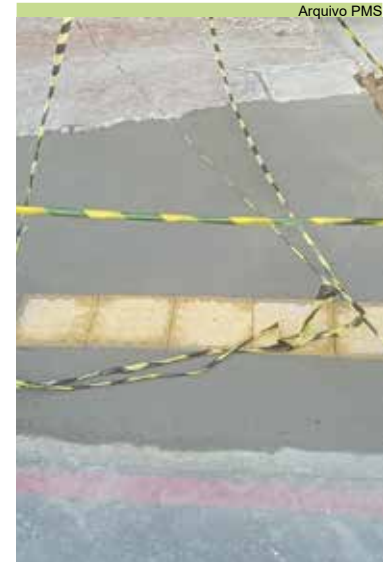
Restauro da rampa de acessibilidade, ao lado da ciclovia, no Emissário Submarino
