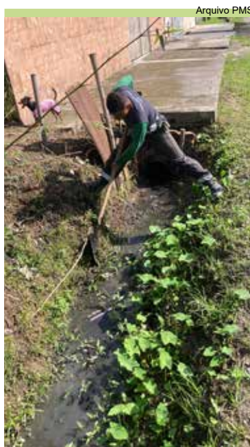
Limpeza de vala na Rua Castelo Branco, no Caruara
