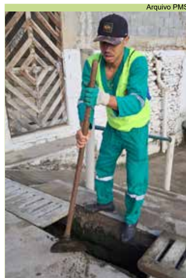
Limpeza de caixas e grelhas no Nicho 02, no Monte Serrat
