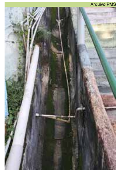
Limpeza de caixas e canaleta na Vila Santa Terezinha
