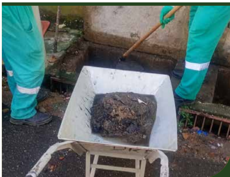
Serviço de limpeza de caixas de passagem na Vila Progresso
