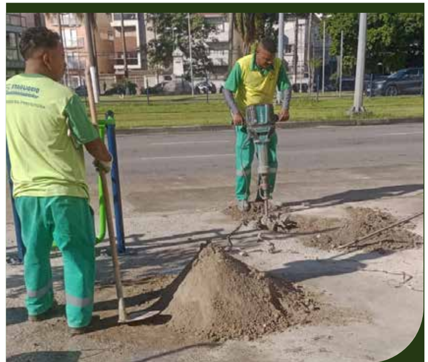
Troca de dois poços de visita no cruzamento das ruas Júlio de Mesquita com Vidal Sion, na Encruzilhada
