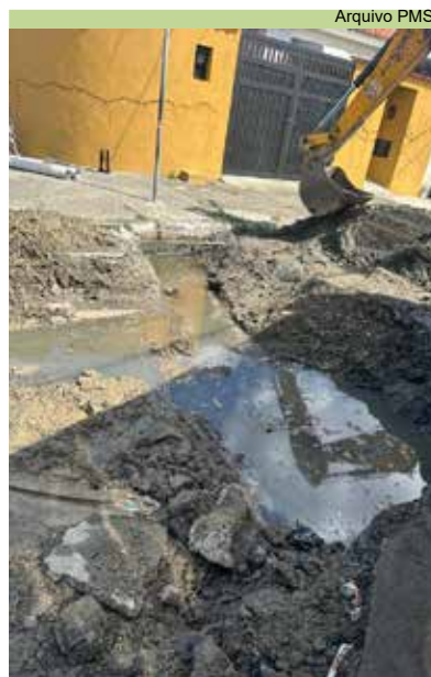
Instalação de laje e poço de visita na Rua José Alberto de Luca, no Rádio Clube
