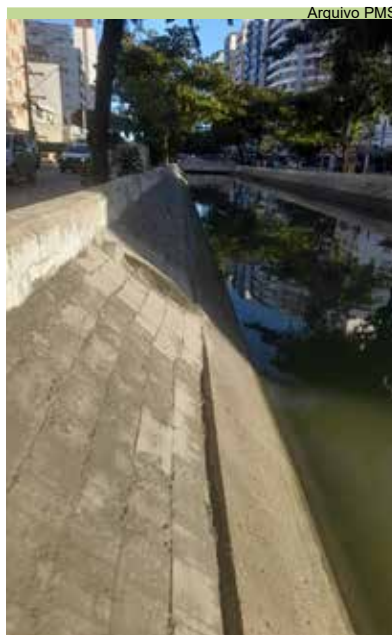
Colocação de argamassa no talude do Canal 1, no José Menino
