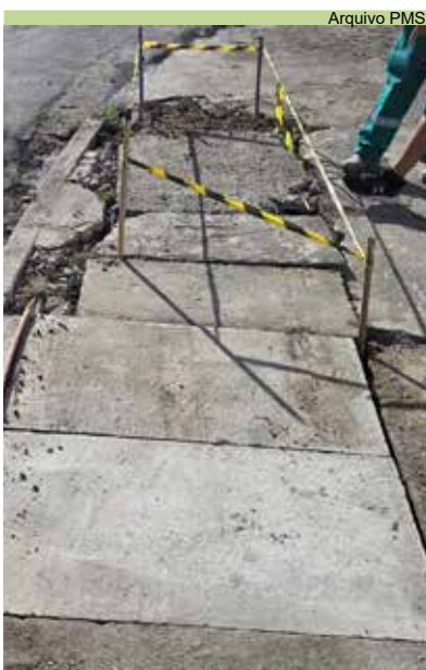
Troca de tampa de concreto no Caminho da Capela, no Castelo
