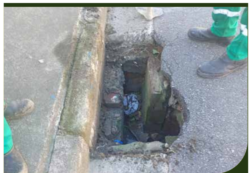
Manutenção em caixa de passagem na Rua Moisés de Freitas, número 563, no Morro Nova Cintra
