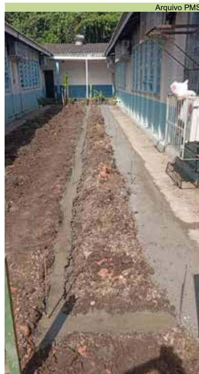
Construção de base para a mureta da horta da UME Judoca Ricardo Sampaio
