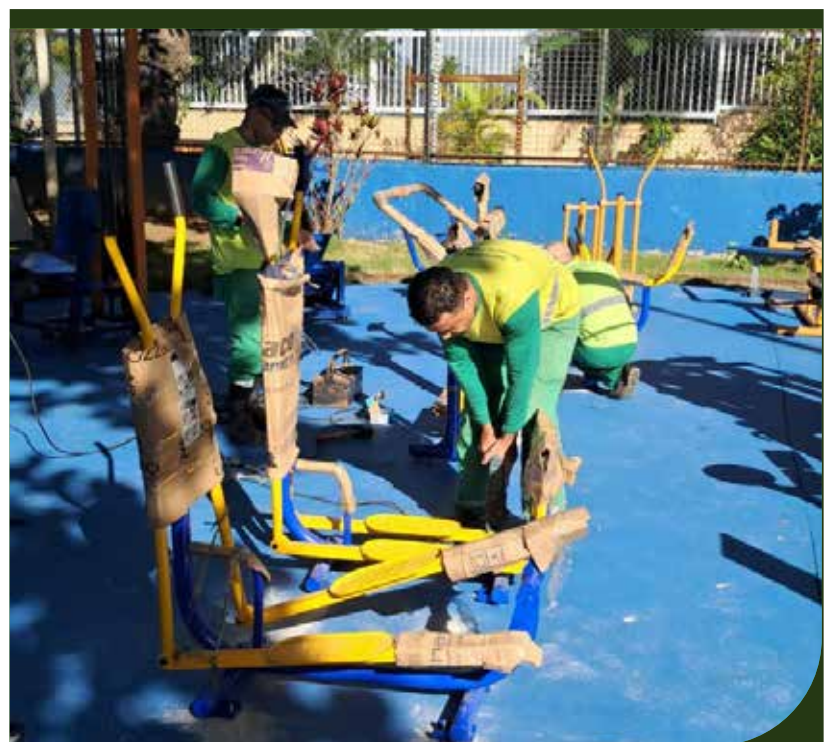
Instalação de aparelhos de ginástica na Academia ao Ar Livre, no José Menino
