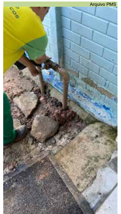
Adequação de registros para o contrapiso na UME judoca Ricardo Sampaio
