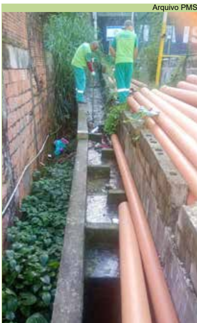
Limpeza de escada hidráulica na Av. João Belchior M. Goulart, no Morro Santa Maria
