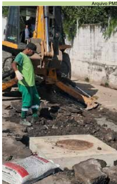
Instalação de laje de poço de visita na Rua Ana Santos, no Chico de Paula
