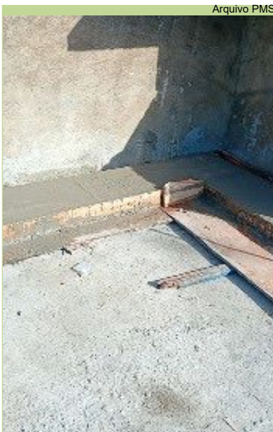
Produção de tampas de concreto
