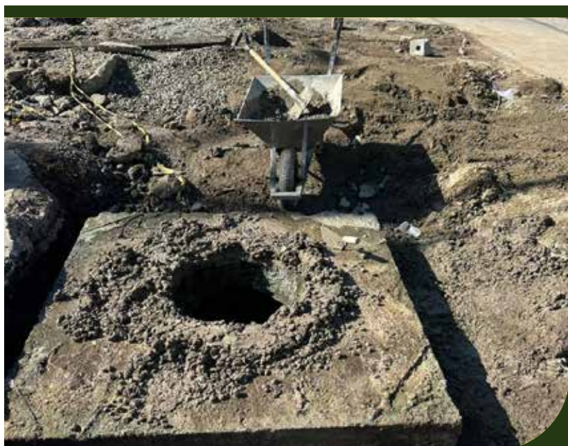
Colocação de laje de poço de visita na Rua Dr. Nilo Rodrigues Paz, em frente ao número 275, no Castelo
