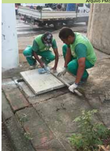
Troca de tampa de concreto na Av. Almirante Cochrane, no Embaré
