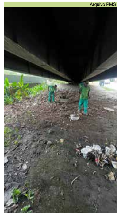
Serviço de limpeza sob a ponte na entrada do bairro Monte Cabrão
