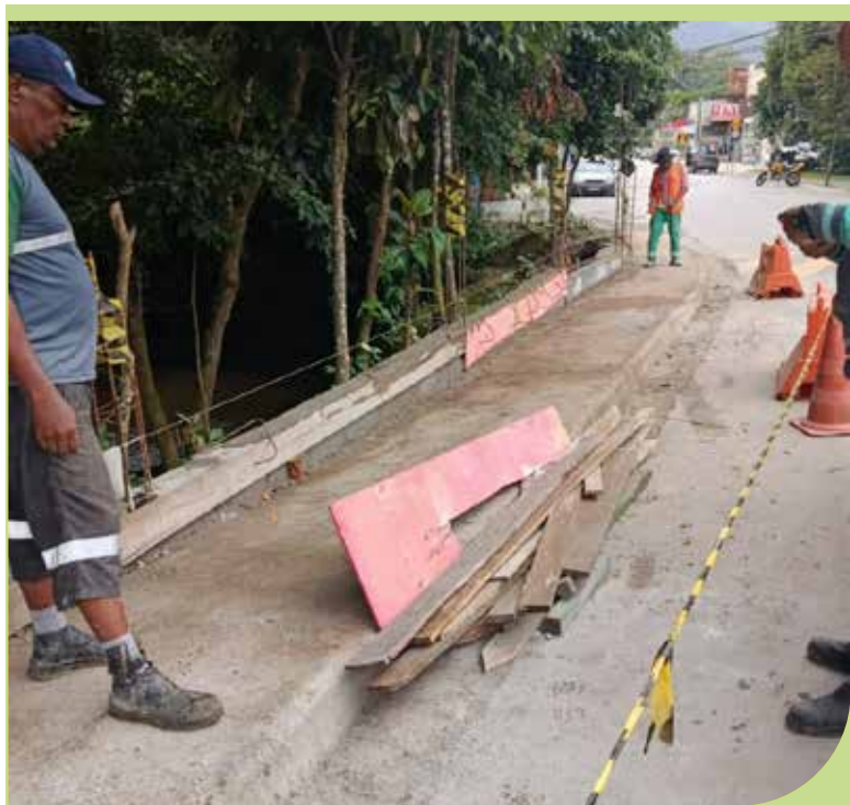
Construção de mureta às margens do Rio Iriri Macuco, na entrada do Caruara
