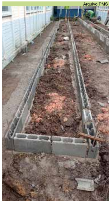
Construção de mureta para horta na UME Judoca Ricardo Sampaio, no Caruara
