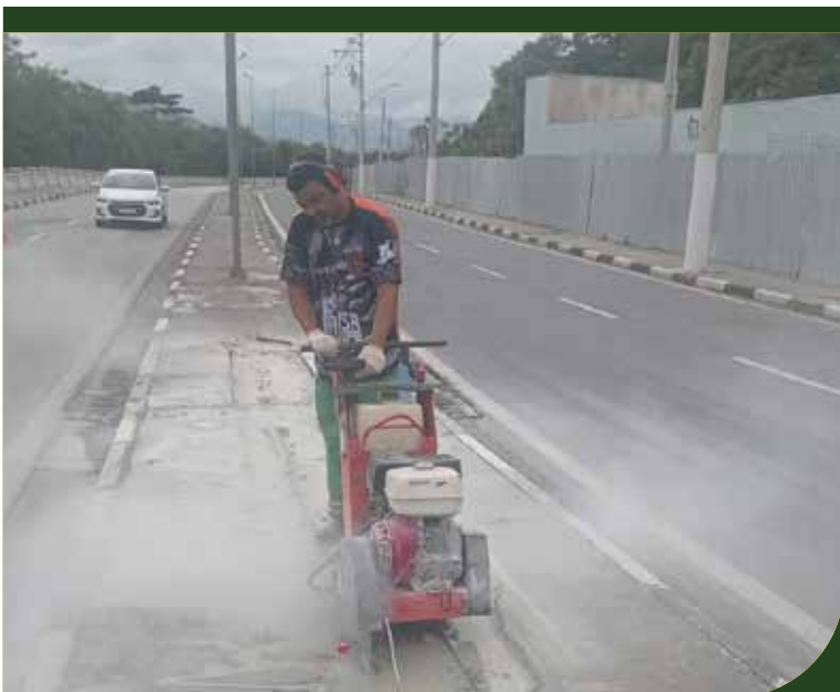
Abertura de canaleta para passagem de cabos na Avenida Jornalista Armando Gomes, no Rádio Clube
