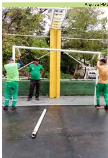
Instalação de traves na quadra esportiva do Ilhéu Alto
