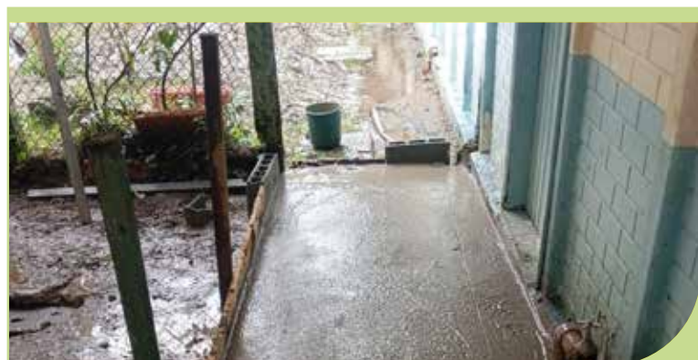
Construção de rampa de acessibilidade para a horta na UME Judoca Ricardo Sampaio, no Caruara
