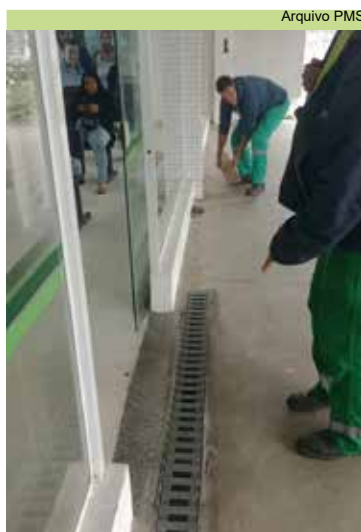
Colocação de grelha ao lado da porta na entrada da Policlínica do Piratininga
