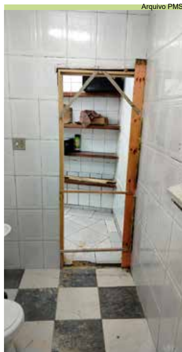
Instalação de batente na Escola em Tempo Integral, no Caruara
