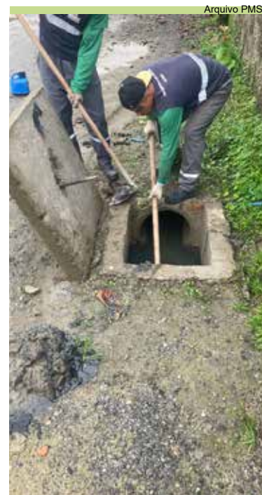
Limpeza das caixas de drenagem nas ruas Palmas e das Oliveiras
