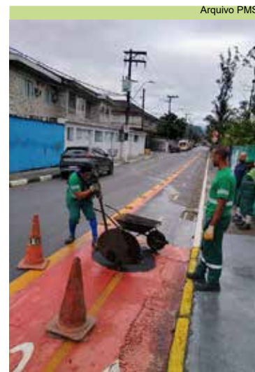
Limpeza de poço de visita na Rua Dr. Pedro Paulo de Giovanni, no Santa Maria
