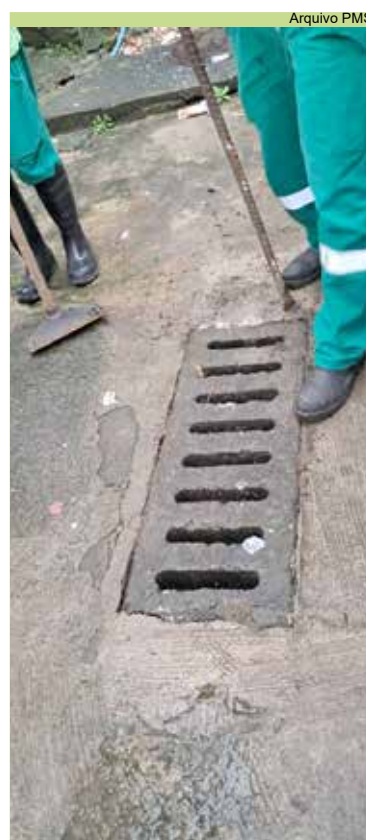
Limpeza de grelha na Rua 10, no Morro Penha
