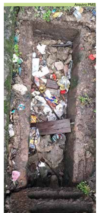
Limpeza de grelhas na Rua 09, no Morro Penha
