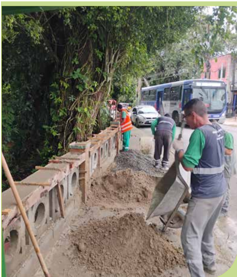
Concretagem da mureta na entrada do Caruara, ao lado do Rio Iriri Macuco
