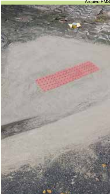
Rampa de acessibilidade é instalada no trecho entre a Caramuru e a Alfaia Rodrigues
