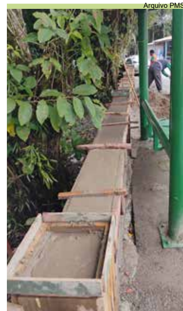
Feita concretagem de forma da mureta para entrada do Caruara
