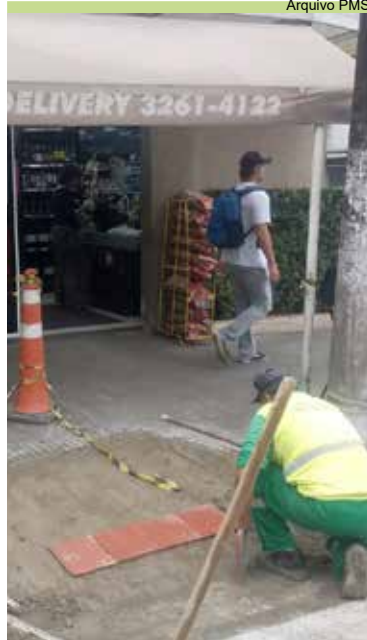
Rua André Vital de Negreiros ganha rampa de acessibilidade
