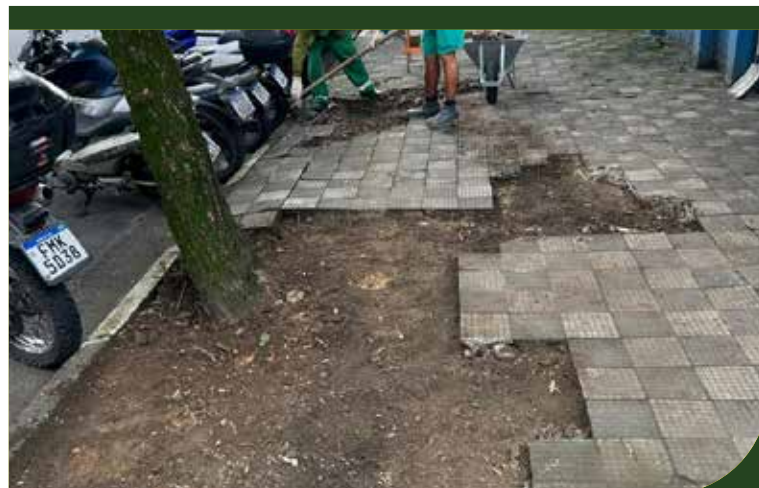
Equipes realizam reparo na calçada da via Aristóteles Menezes, na Ponta da Praia
