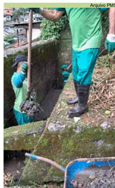
Serviço de limpeza de caixas, canaleta e hidráulica na Rua 2, Penha
