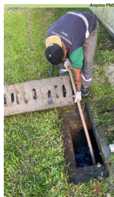
Limpeza de caixas de drenagem nas ruas Tamoios e Trusilva
