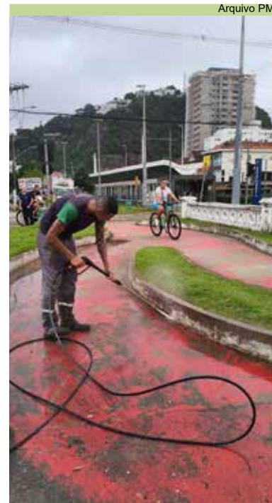
Limpeza no pontilhão do Canal 1, próximo à estação do VLT
