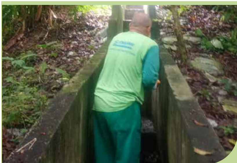
Limpeza de caixas e hidráulica na Alameda José Gomes, na Caneleira
