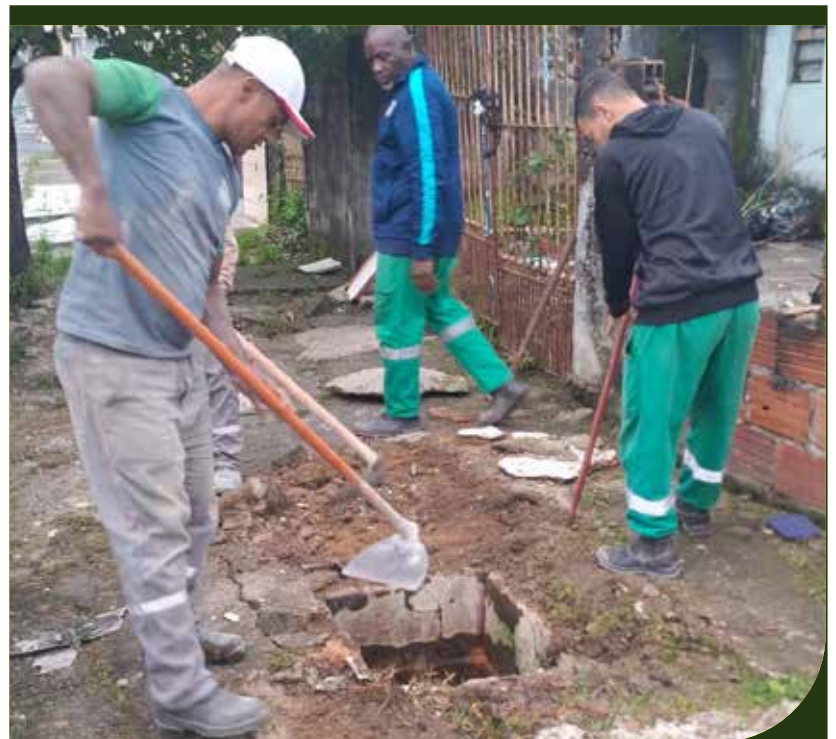
Troca de tampa de concreto na calçada da Rua João Osório da Fonseca, número 137, no Bom Retiro
