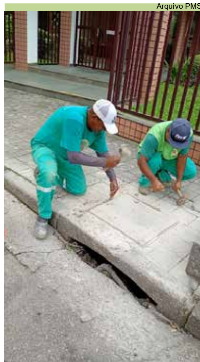
Manutenção de caixa de drenagem na Rua Egídio Martins, na Aparecida
