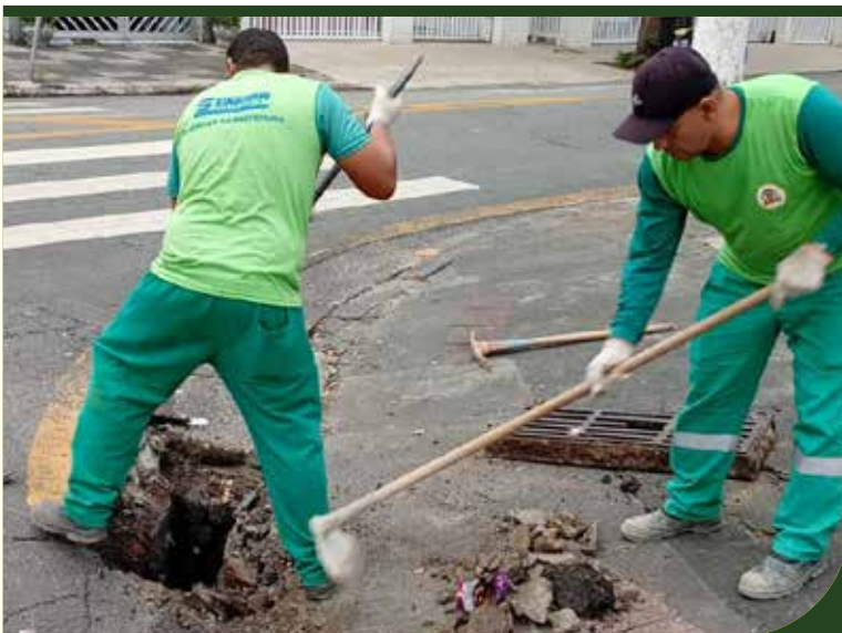
Troca de grelha de boca de lobo na esquina das ruas Álvares Cabral e Dom Pedro I, na Vila Belmiro
