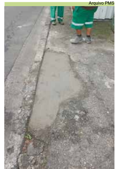
Reparo na calçada na Rua Frei Francisco Sampaio com Rua Jurubatuba
