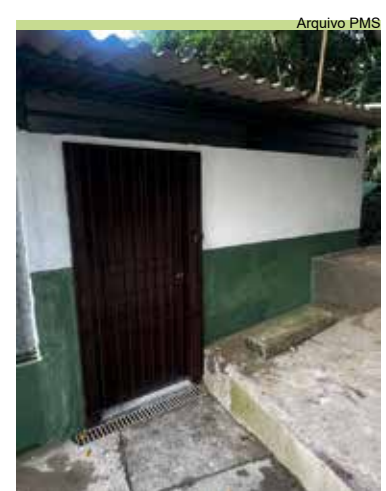
Serviço de pintura da base de apoio no Monte Cabrão
