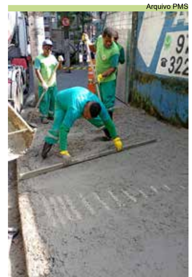
Concretagem de calçada na Rua Pedro Borges Gonçalves, no José Menino
