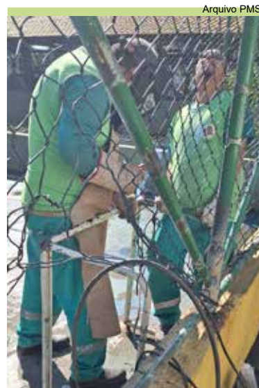
Reparo no alambrado e na trave da quadra de futebol da Praça da Aparecida
