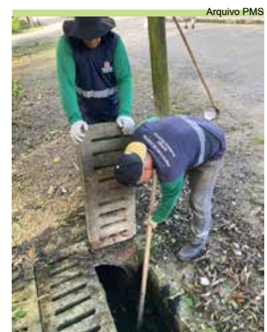
Limpeza de caixas de drenagem das ruas 1, 2 e 3, no Caruara
