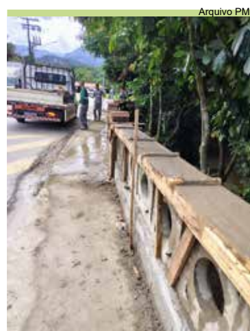
Concretagem das formas da mureta tipo bolinha na entrada do Caruara
