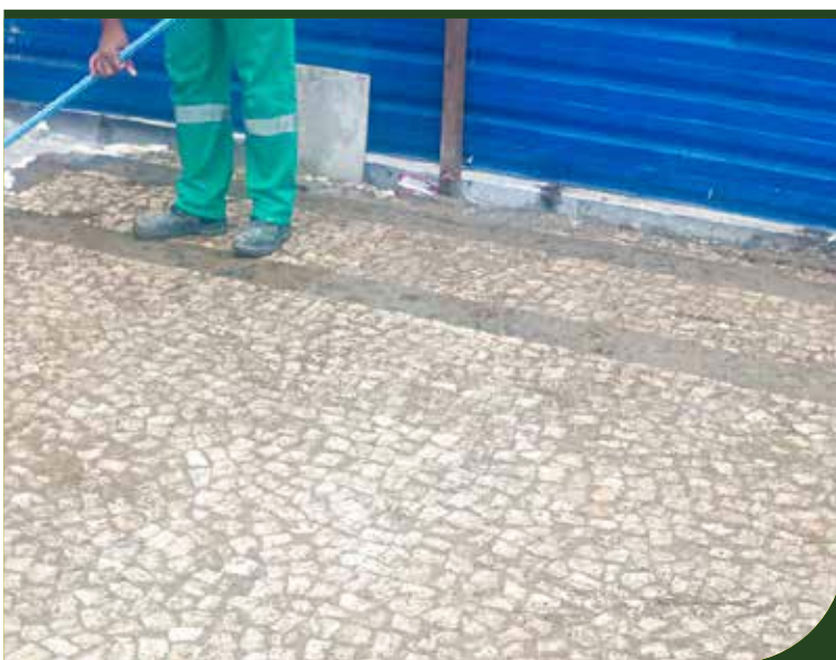
Aplicação de rejunte no piso mosaico na Praça Independência, no Gonzaga
