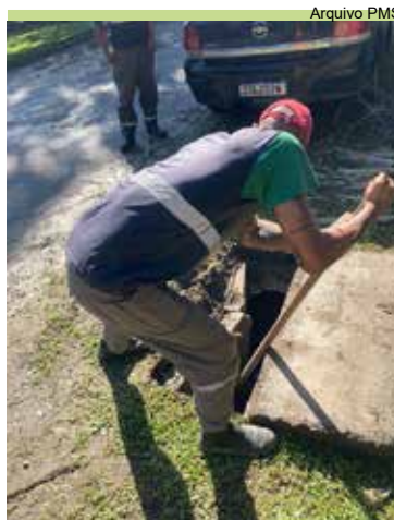
Limpeza de caixas de drenagem das ruas Silva Regina, 5 e 6, no Caruara
