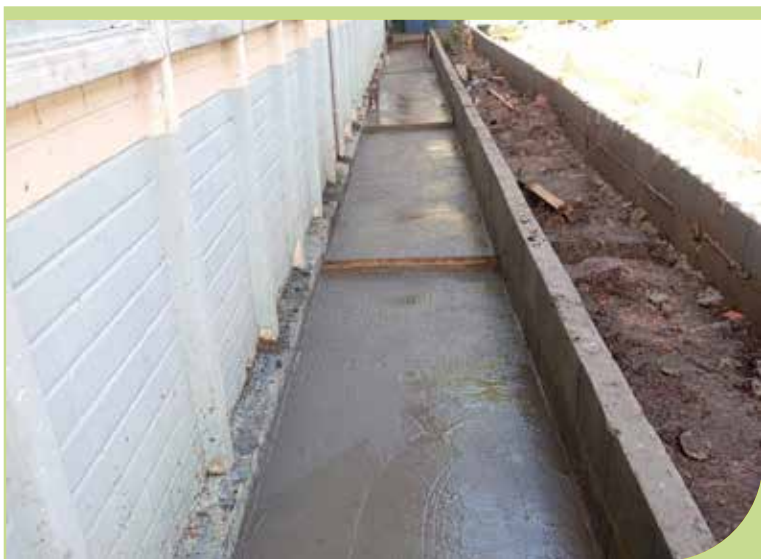
Concretagem de calçada no entorno da horta na UME Judoca Ricardo Sampaio Cardoso, no Caruara
