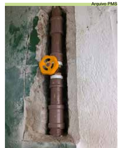
Instalação de registro de água na Policlínica do Monte Cabrão
