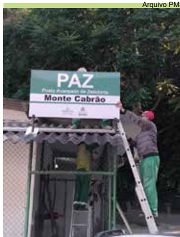
Instalação de placas da veterinária e da base de apoio do Monte Cabrão
