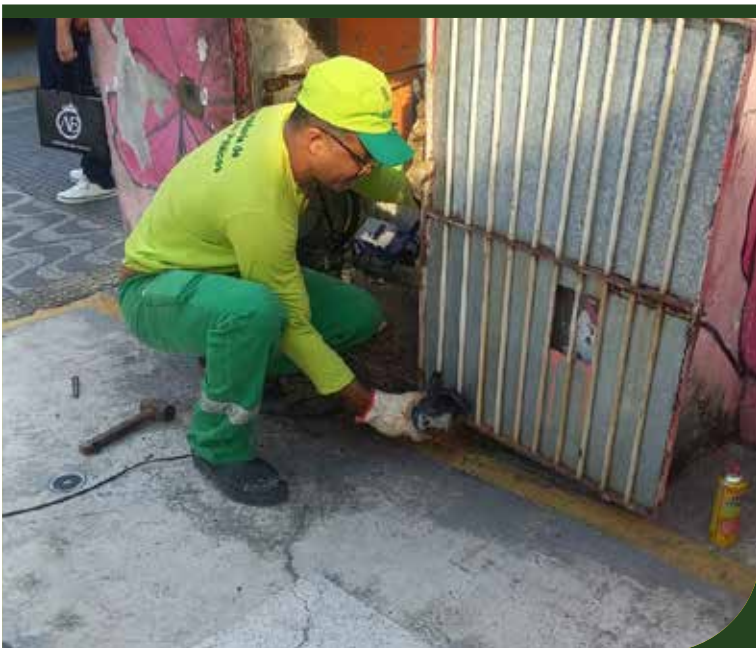
Reparo na grade de proteção do registro de água do Instituto da Mulher, no bairro Encruzilhada
