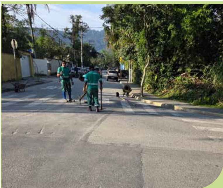
Limpeza das caixas de drenagem e poço de visita na Rua Andrade Soares, no Caruara
