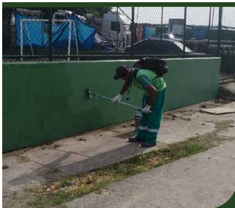
Pintura das jardineiras, conjuntos de bancos, mesinhas e mureta externa na Praça Fernando Oliva, no Bom Retiro
