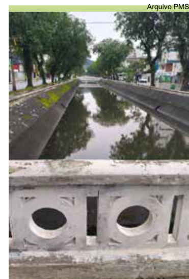
Serviço de manutenção e limpeza do talude do Canal 1
