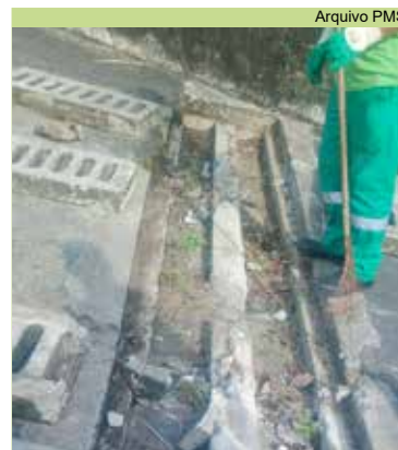
Limpeza de grelhas e escada hidráulica na Rua 2, no Morro Marapé
