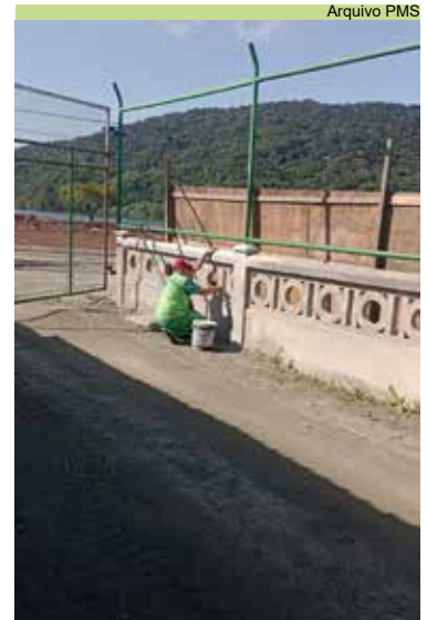
Pintura da mureta na Coordenadoria Técnica (Cortec)
