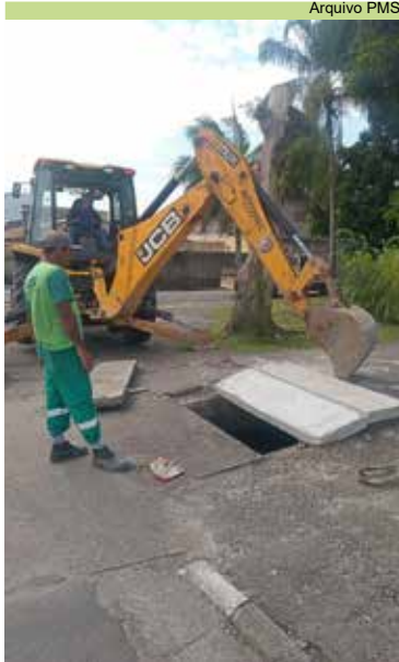
Instalação de duas tampas de concreto na Rua Waldemar Noschese
