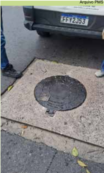
Troca em tampa de poço de visita na Praça José Oliveira Lopes, no Rádio Clube
