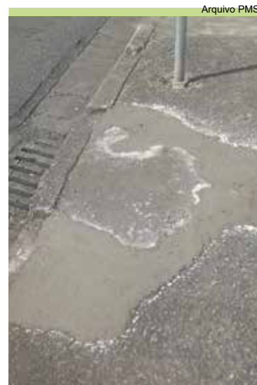
Reparo com massa na calçada da Rua Jurubatuba, na Aparecida
