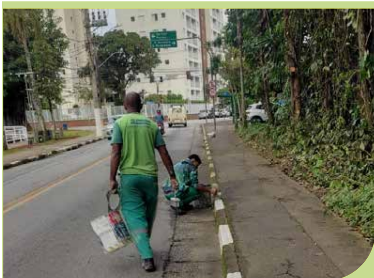
Pintura de guias e postes na Avenida Antônio Manoel de Carvalho, no Morro Nova Cintra
