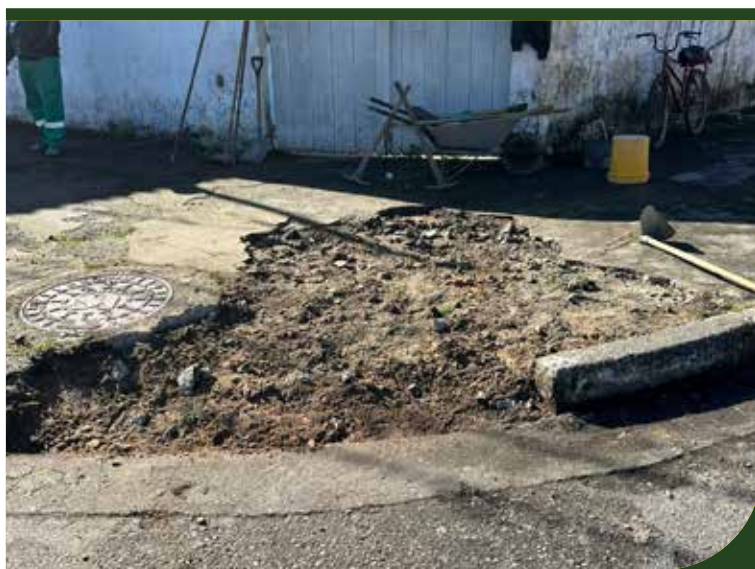
Preparação de três rampas de acessibilidade entre as vias Hugo Maia e Santa Rita de Cássia
