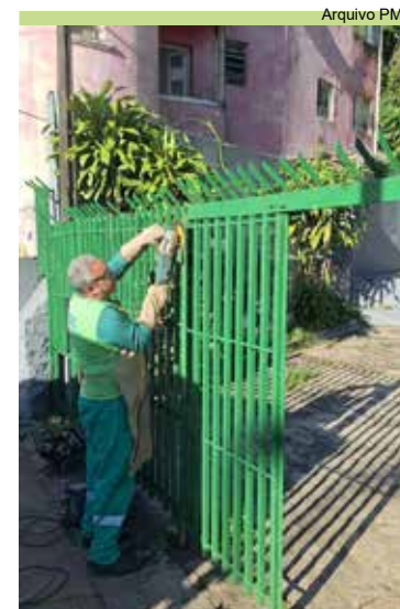
Área da gruta da via Santa Catarina recebeu trabalhos de conservação
