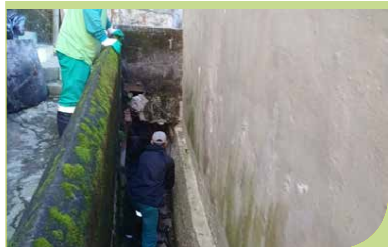
Limpeza de canal na Rua Maria Neusa Cunha, no Morro Jabaquara
