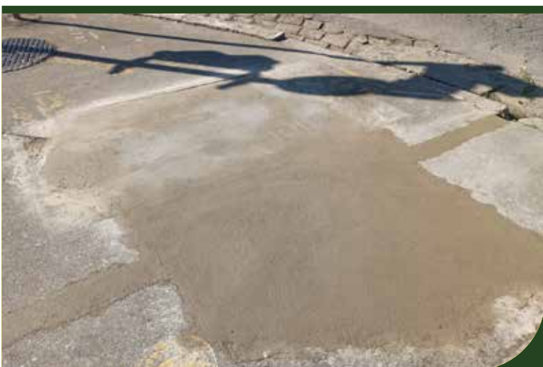
Concluído reparo em calçada no trecho Bartolomeu de Gusmão x Francisco Glicério
