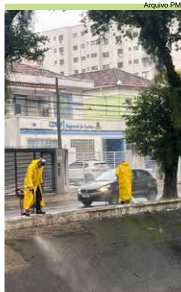
Zeladoria realizou lavagem e manutenção do Canal 1
