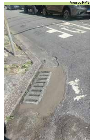
Vila Belmiro: bocas de lobo passaram por ações de reparo
