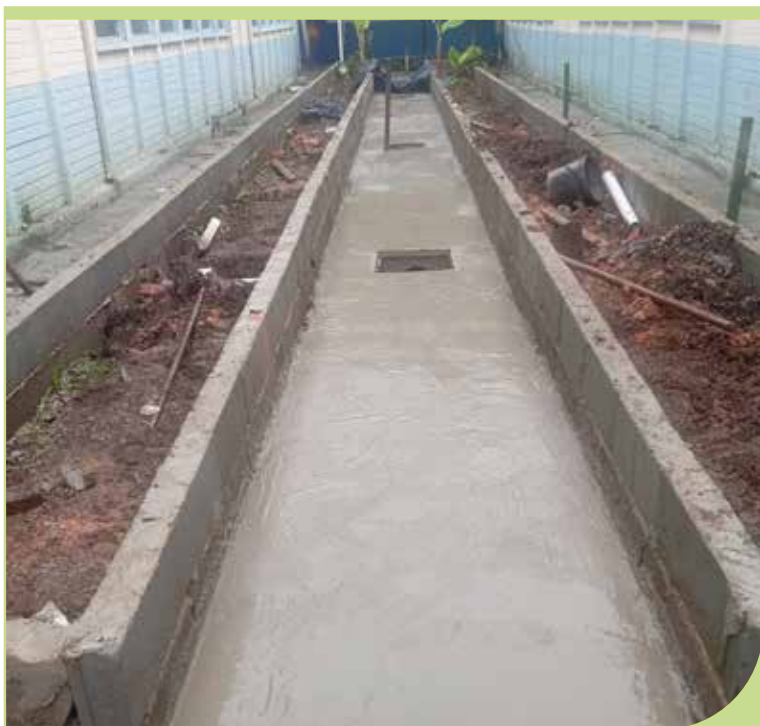
Concluída concretagem para horta na UME Judoca Ricardo Sampaio
