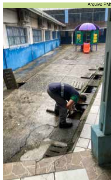
Realizada limpeza de caixas de drenagem em escola do Caruara
