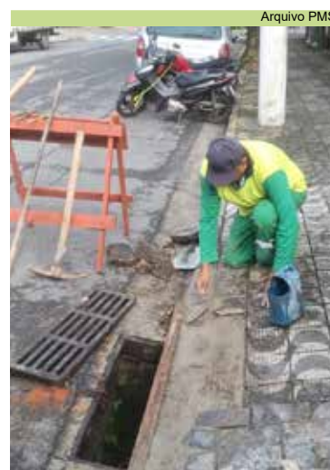
Reparo de abatimento na Rua Dona Maria Máximo, nº 115
