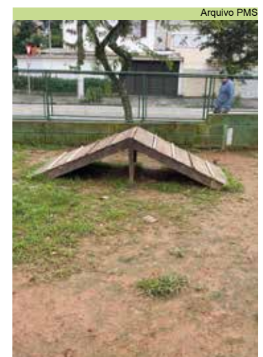
Concluído reparo em rampa no espaço pet da Praça Evelina Alca
