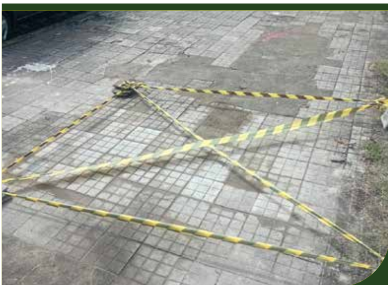
Finalizo reparo em calçada no trecho Rua Carvalho de Mendonça x Avenida Senador Pinheiro Machado
