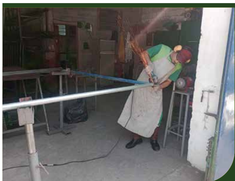
Produção de quadros para alambrados que serão instalados ao lado do bloco A no Centro Cultural, na ZNO
