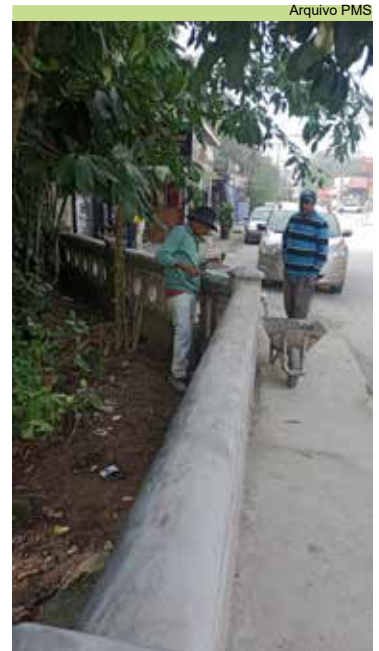
Finalização da construção da mureta na entrada do Caruara
