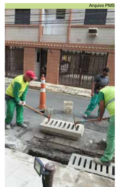
Colocação de boca de lobo na Rua Particular Lélia, na Aparecida
