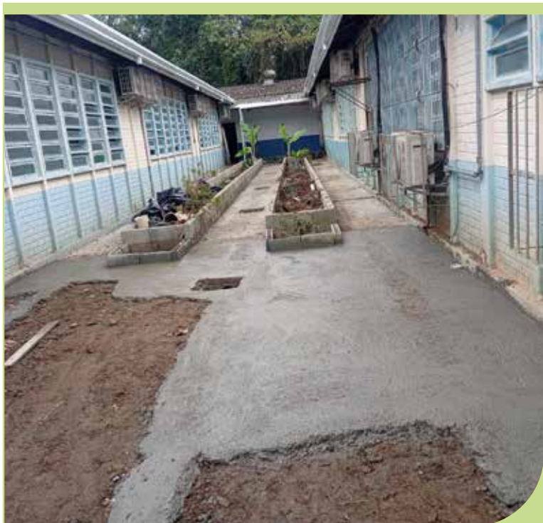
Concretagem de calçada no entorno da horta na UME Judoca Ricardo Sampaio Cardoso, no Caruara
