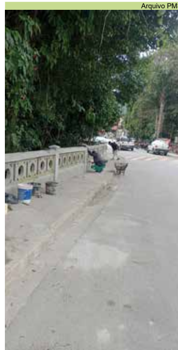
Serviço de manutenção de mureta na entrada do Caruara
