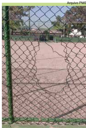
Vistoria na quadra esportiva da Praça Doutor Augusto Cerqueira, no Castelo
