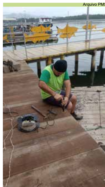
Instalação de guarda-corpo e flutuante do píer da Ilha Diana
