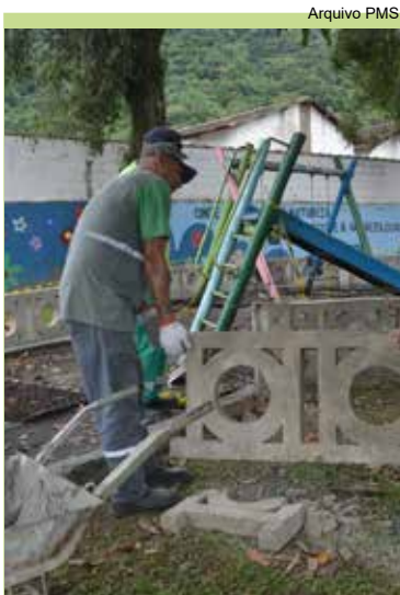
Colocação de guarda-corpo na Praça Albertino Moreira, no São Jorge
