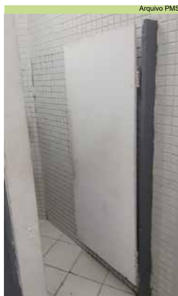
Serviço de manutenção nas portas dos banheiros do Canal 4
