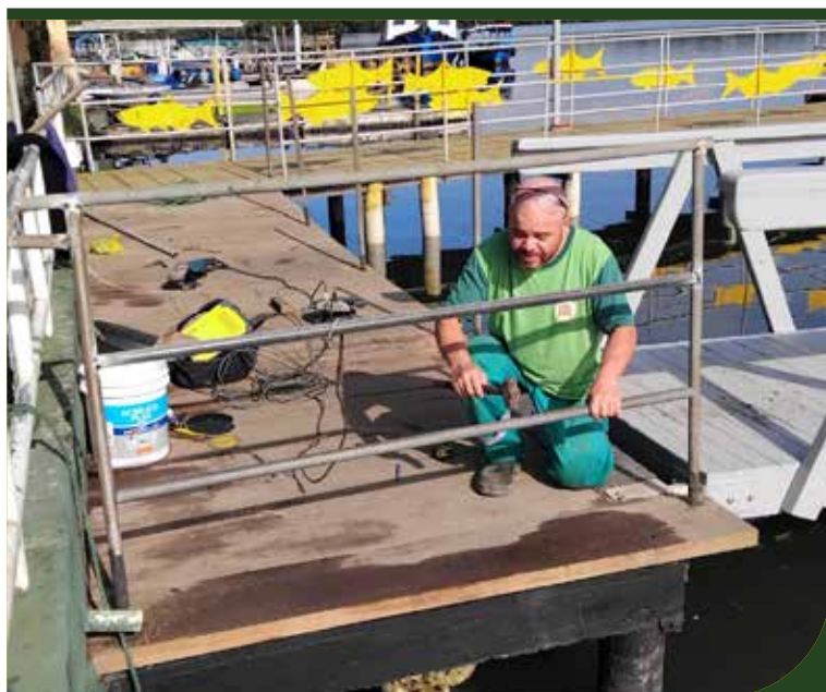
Colocação de guarda-corpo no flutuante do píer da Ilha Diana
