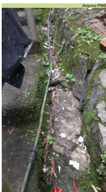
Limpeza de córrego na Rua 13, no Morro Penha
