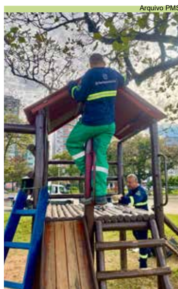
Conserto no telhado da Casa do Tarzan, na orla da praia do Canal 2
