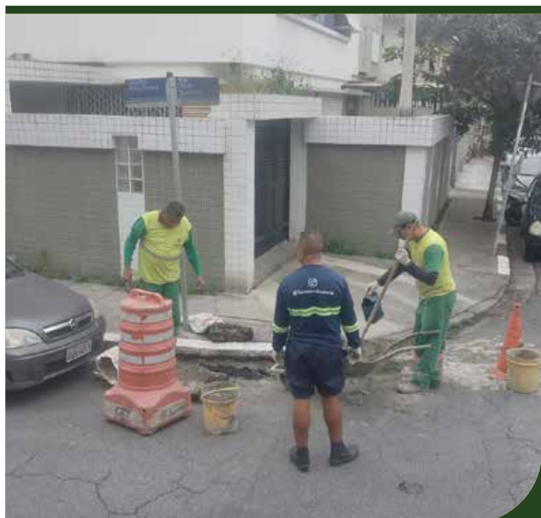
Nivelamento de sarjeta no cruzamento das ruas Otávio Spagnolo com Professor Primo Ferreira, no Boqueirão
