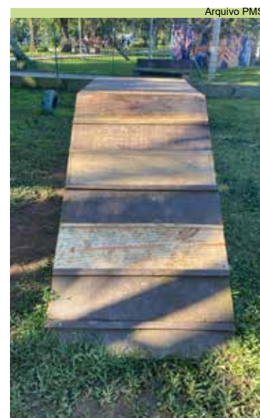
Manutenção nas rampas de madeira do Espaço Pet
