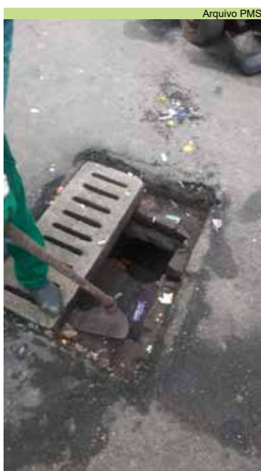
Limpeza de grelhas na Rua 9, no Morro Penha
