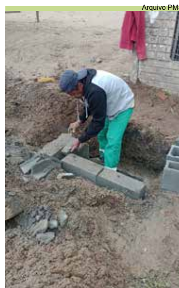
Construção de caixa de passagem na Rua 4, no Caruara
